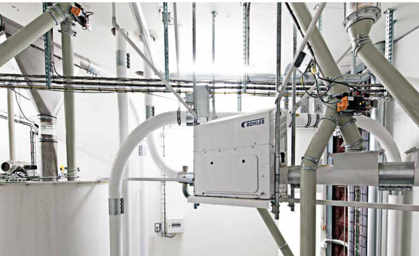
Tube ist das einzige rohrförmige Fördersystem der Welt, das einzelne Schubelemente kontinuierlich schiebt.
